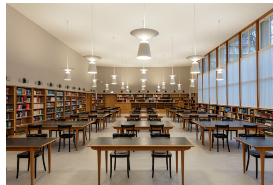
Die Doppelkelchlampen waren für die ursprüngliche Raumstimmung im Lesesaal entscheidend. Deshalb wurden Replikat mit neuester LED Technik nachgebaut, die diese Stimmung wieder zu erzeugen vermögen und die erforderlichen 500 Lux fürs Arbeiten gewährleisten.
