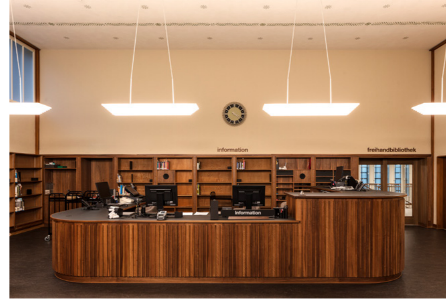
Die Infothek im Katalogsaal sieht fast so aus wie das Original. Das Farb- und Materialkonzept der Sanierung ist abgeleitet von den am Bau verwendeten natürlichen Baumaterialien aus Stein und Holz. Für den Katalogsaal wurde Nussbaumholz und für die Regale im Freihandbereich Ulme verwendet. Bistro und Lesesaal wurden mit Eschenholz ausgestattet.
