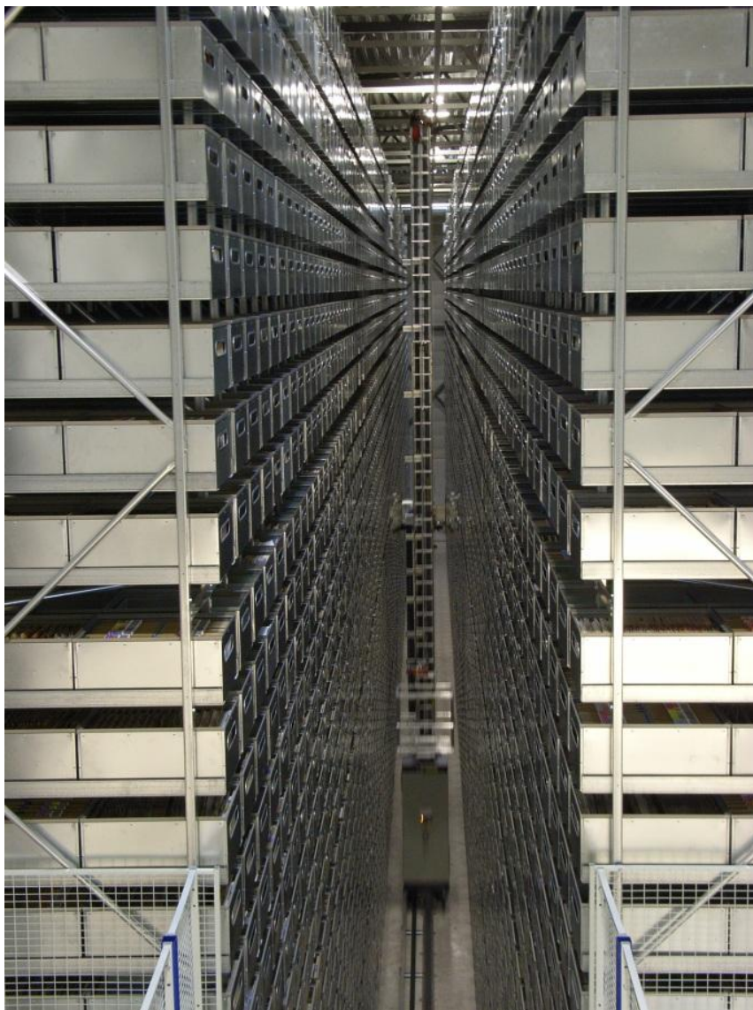
Automatisiertes Hochregallager in Mo i Rana, Norwegen. (Foto: U. Niederer)
