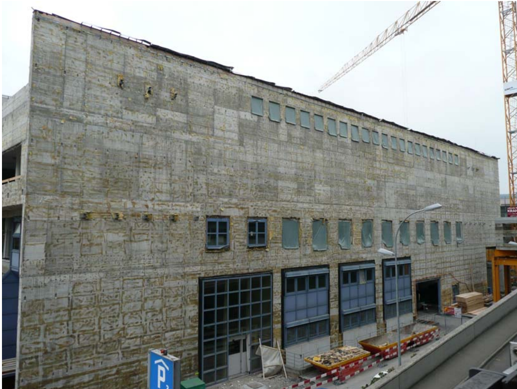
Umbau des ehemaligen Postbetriebsgebäudes für die Universität und die PHZ
