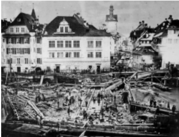
Im Winter 1859/60 baute man in der Reuss das Nadelwehr, um den Wasserstand des Vierwaldstättersees regulieren zu können. Photographie, aufgenommen während der Bauzeit
